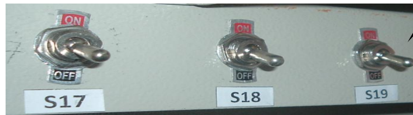
Hình 10.8: Kiểm tra công tắc hành trình S19 .
