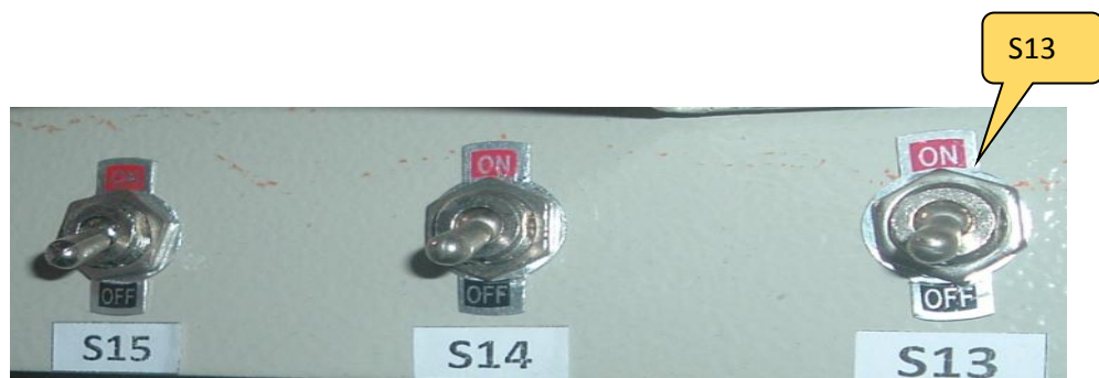
Hình 10.3: Kiểm tra công tắc hành trình S13
