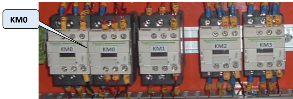
Hình 7.12: Kiểm tra công tắc tơ KM0.
