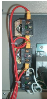
Hình 11.3: Kiểm tra nút nhấn.
