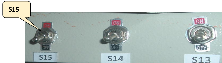
Hình 10.5: Kiểm tra công tắc hành trình S15 .
