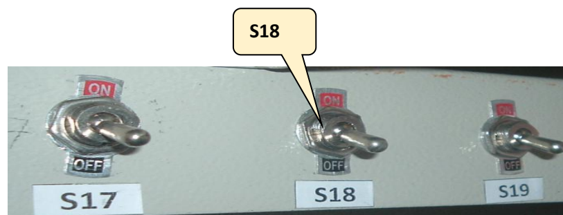
Hình 10.7: Kiểm tra công tắc hành trình S18 .
