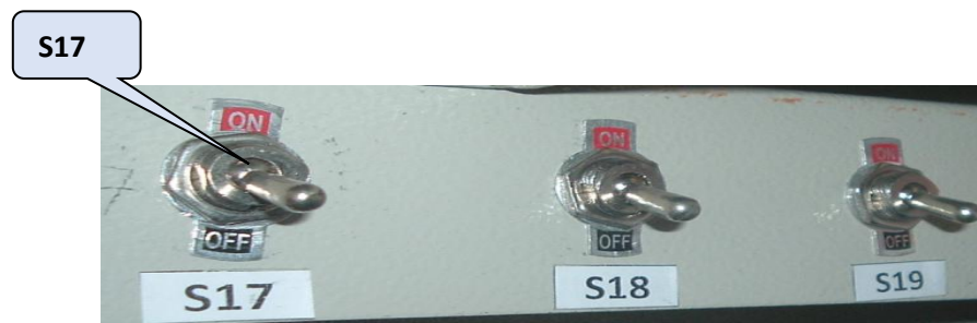
Hình 10.6: Kiểm tra công tắc hành trình S17 .
