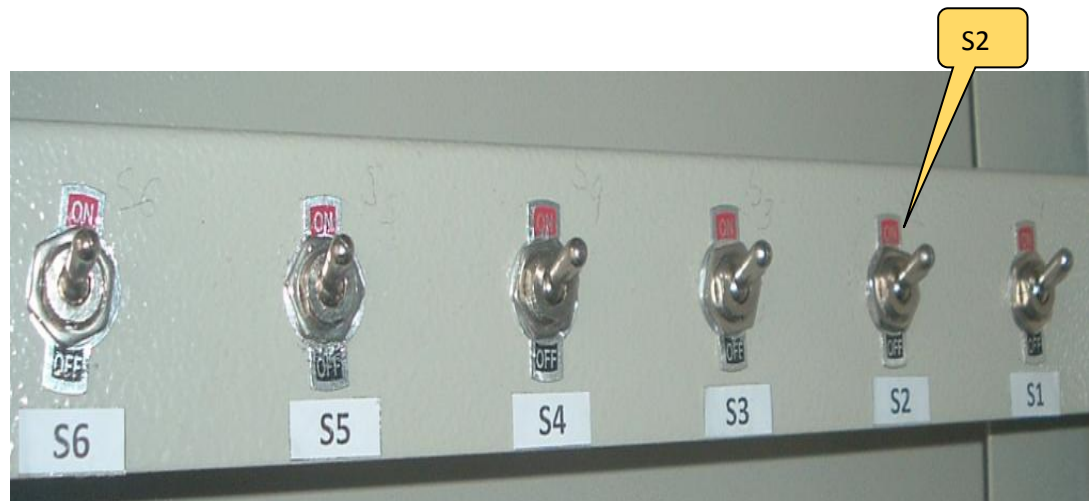
Hình 7.11: Kiểm tra tiếp điểm của công tắc S2 .
